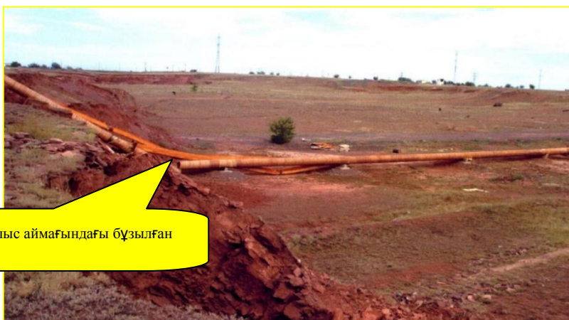
3-сурет. Коммуникациялардың опырылу аймағындағы көрінісі
